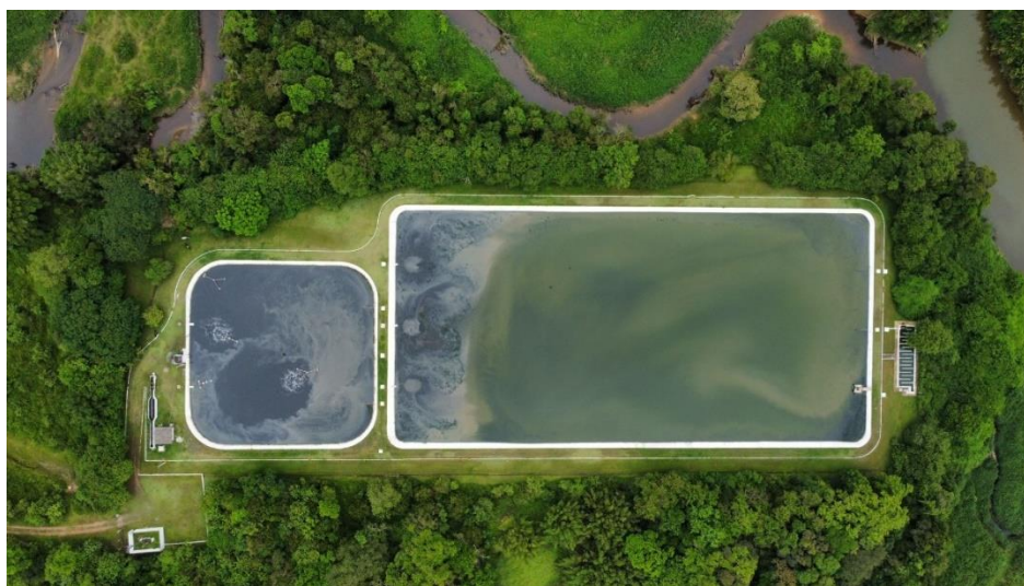
Imagem 28- Estação de Tratamento de Esgoto – ETE SEDE
