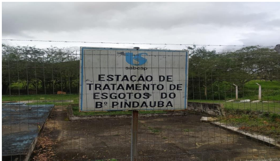
Imagem 29- Estação de Tratamento de Esgoto – ETE PINDAÚBA
