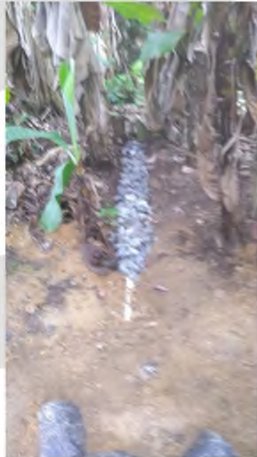
Lastro de Brita Vala de Infiltração
